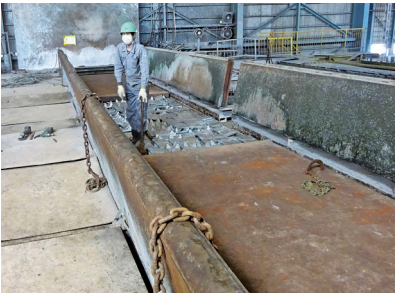
新たな槽内に亜鉛を充填したところ。その後、全体に蓋をする
